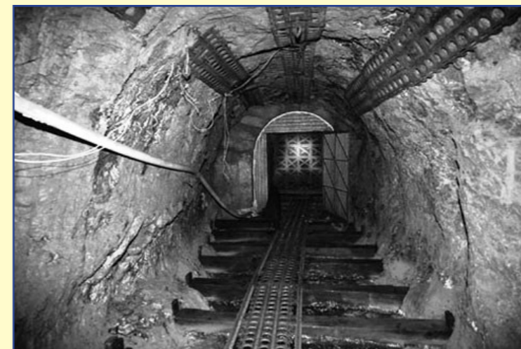
Interno della galleria
