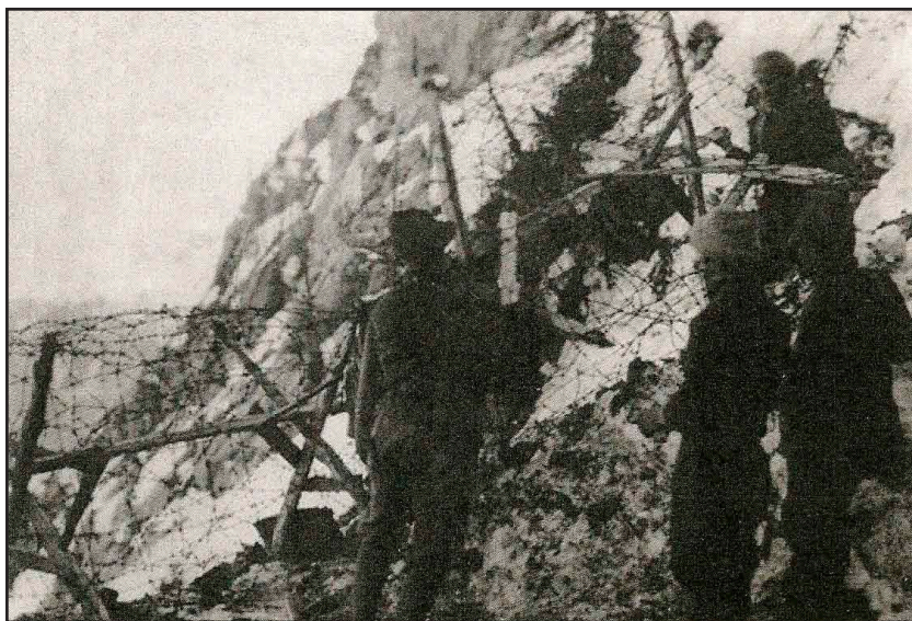
Messa in opera di cavalli di Frisia sul Freikofel
