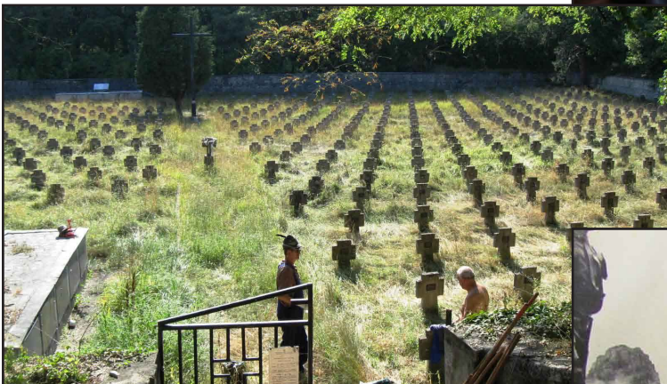
4 agosto - Prosecco: lavori di sistemazione al Cimitero Austoungarico.
