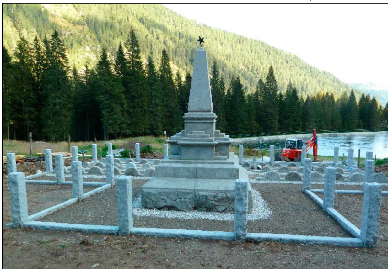
Sotto: il monumento ancora in fase di restauro
