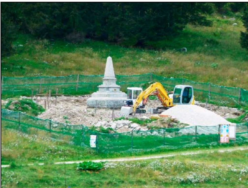
Lavori di restauro
