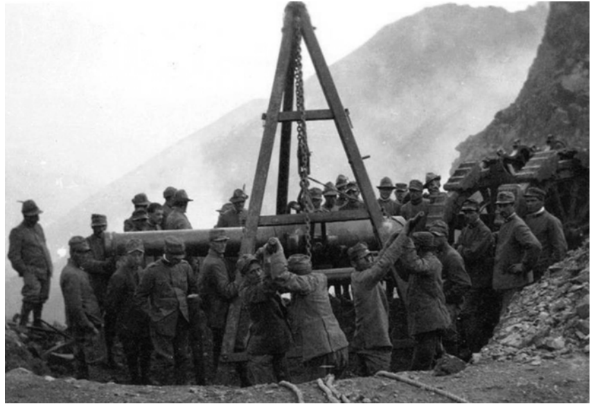
Il lavoro è quasi alla fine, la canna del cannone da 149G viene posato sul suo affusto. Chi opera sono artiglieri, gli alpini del "Feltre" dopo il traino si limitano a guardare. L'ufficiale sulla sinistra è Guido Corsi. Forcella Magna, quota 2117, 2 novembre 1915. (Archivio Garbari, Pergine Vals.)
